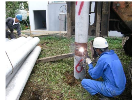
写 溶接継手
