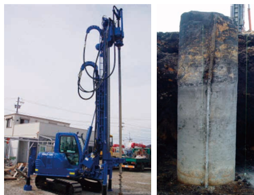
写真-5 柱状改良施工機・柱状改良体 3)
