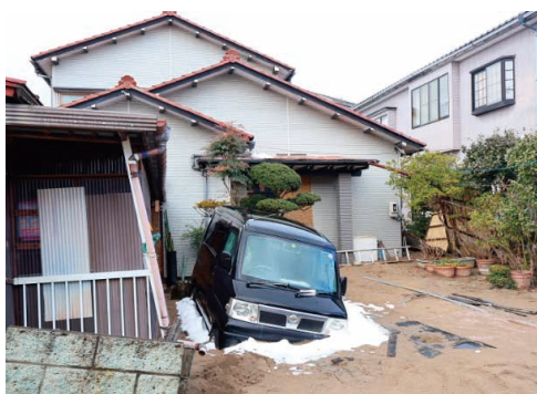
写真-7 液状化被害事例（噴砂 不同沈下） 4)
