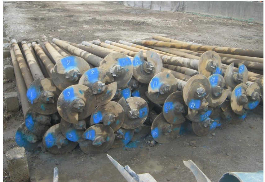
— 引抜後の鋼管 —
