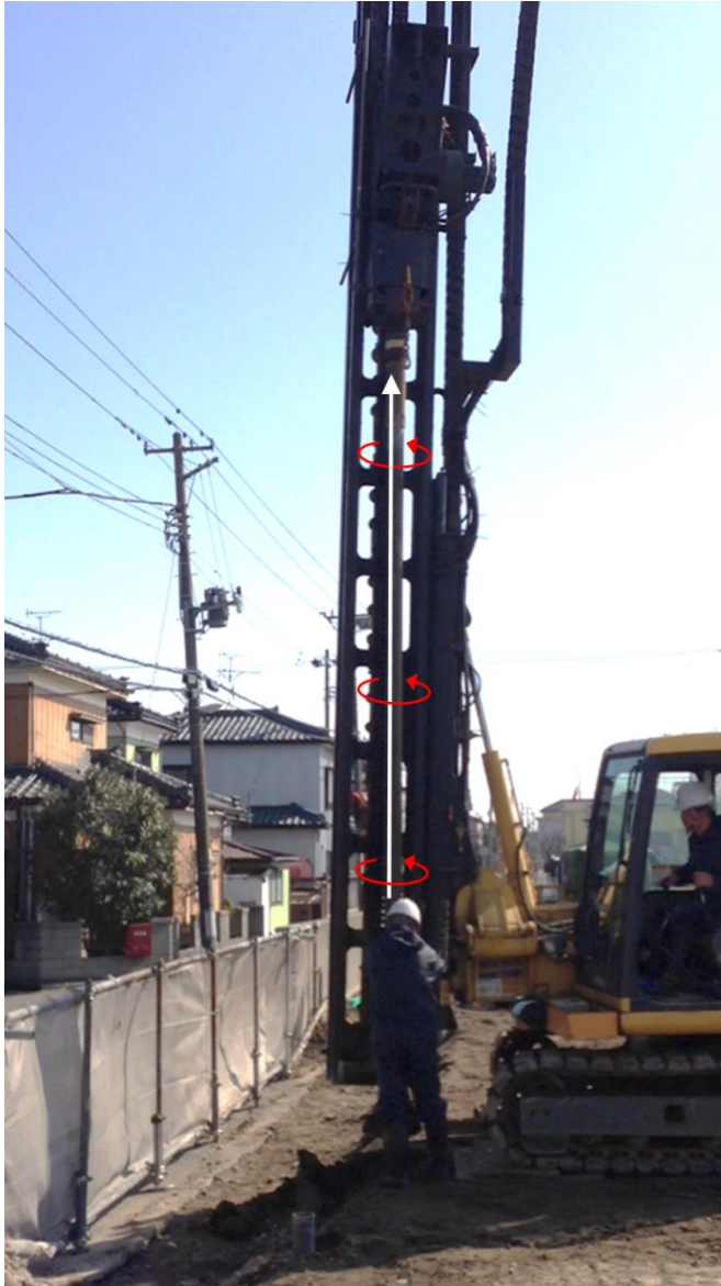
— 引抜き作業の状況 —
