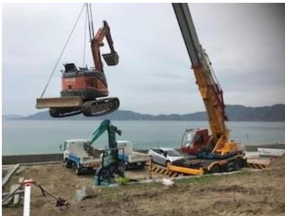
機械搬入状況 (吊り上げ状況)
