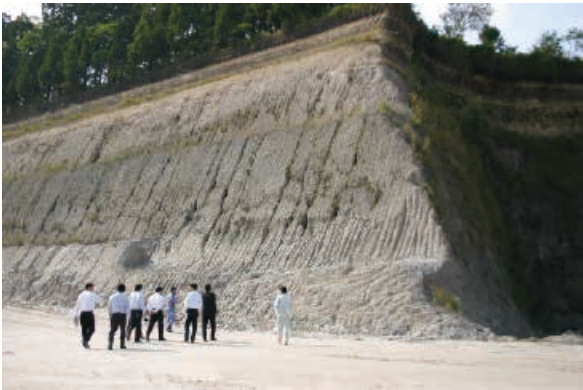
写真-1 垂直崖の侵食面を形成しているシラス地盤
