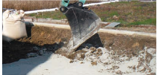
写真-1 粘土混じりの音地土:手に持つと軽く、粘土質である。 (香美市土佐山田町の表層改良の現場にて)
