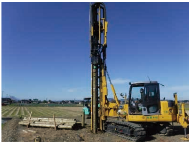
写真-2 環境パイル工法施工状況
