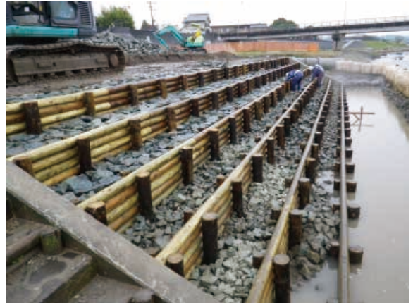
写真-1 合志川 杭柵工
