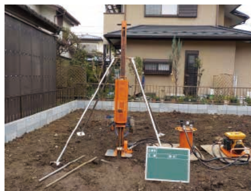
写真-2 中型動的コーン貫入試験の概況（半自動） （ミニラムサウンディング）
