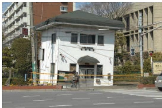
写真-1 液状化で傾斜した交番（浦安市）
