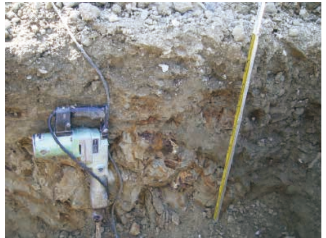
写真-1 土丹層の断面の例
