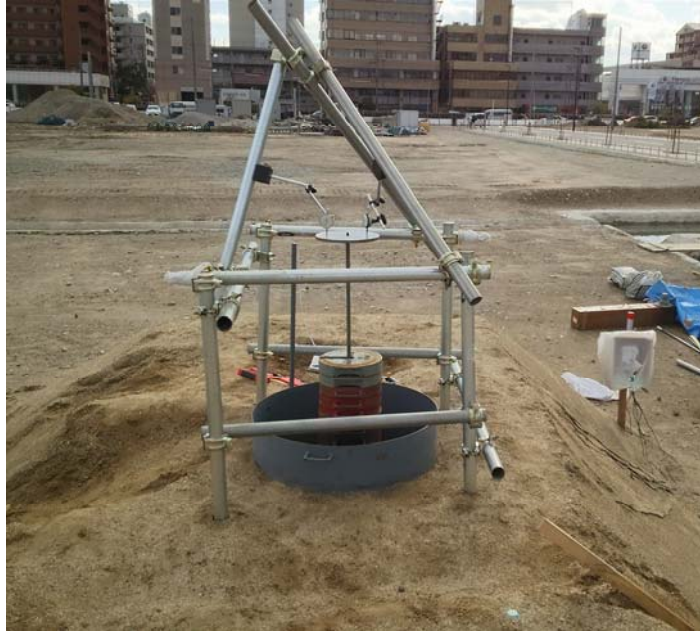
写真-2.6 水浸沈下試験の様子(据置型の沈下量計測)
