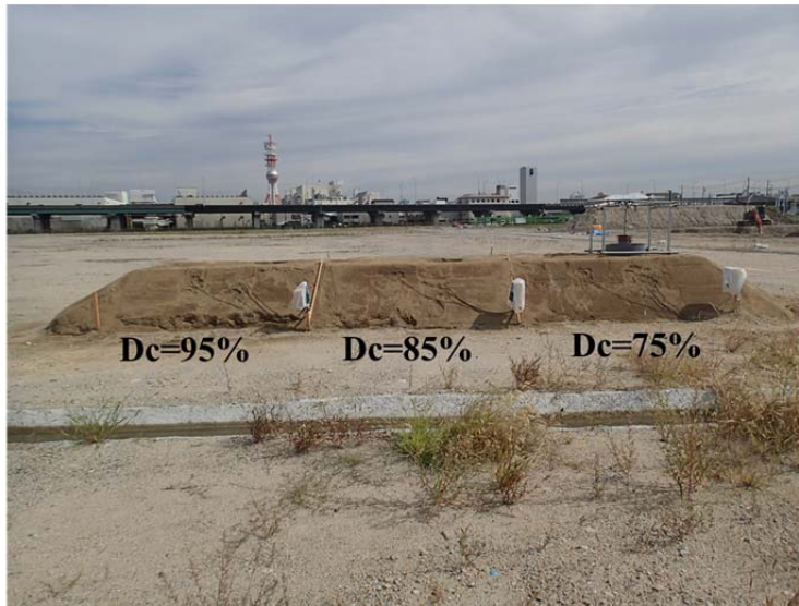
写真-2.2 試験盛土全体の様子
