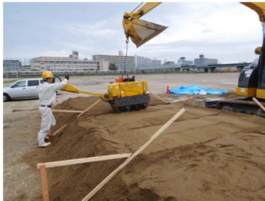
Dc=85%盛土(ハンドローラーでの締固め(0.5 往復))
