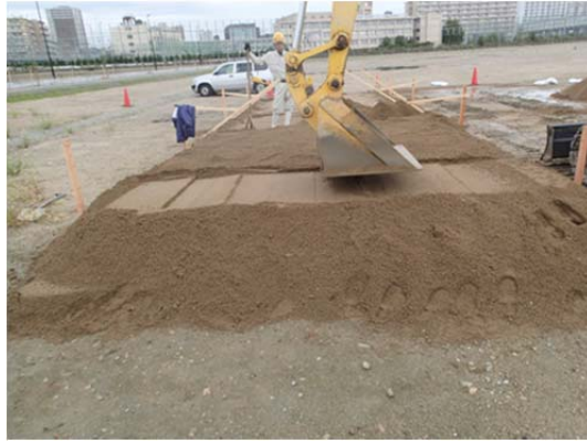
Dc=75%盛土(バケットでの締固めのみ)
