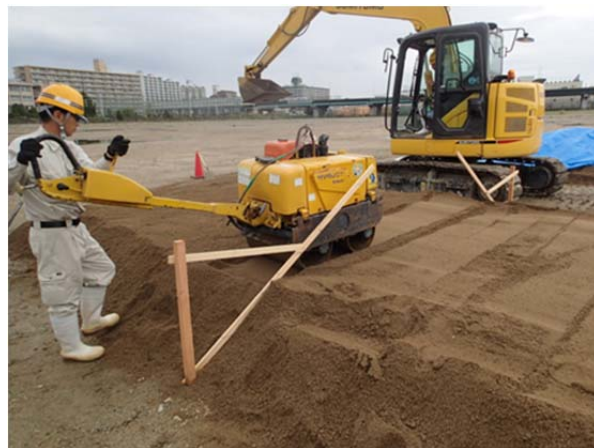
Dc=95%盛土(ハンドローラーでの締固め(10 往復))
