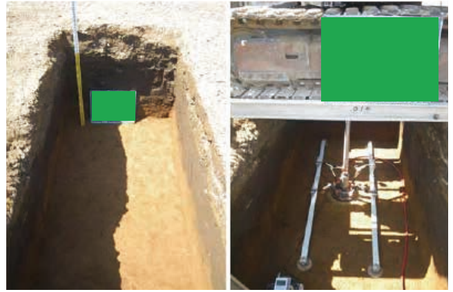
写真-4 平板載荷試験状況
