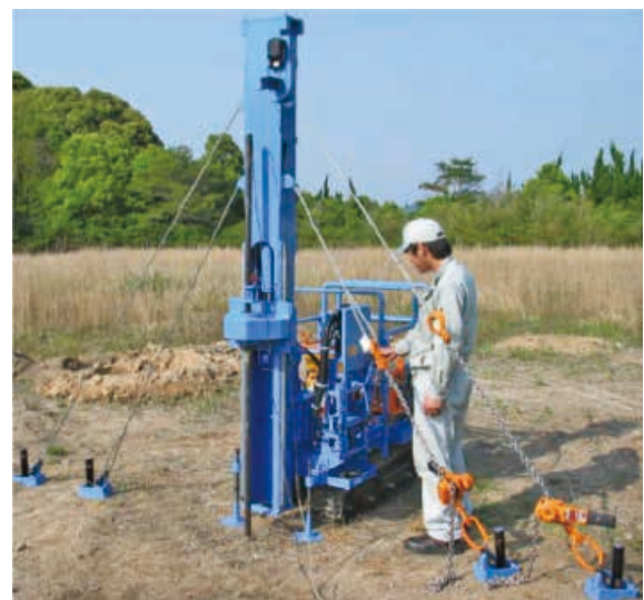
写真-2 CPTの試験状況
