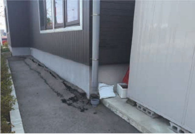
写真-1 杭の抜け上がり現象
