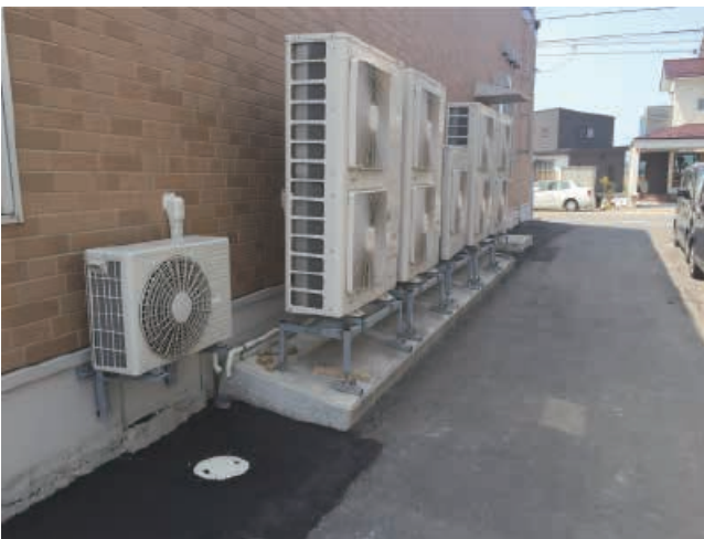
写真-2 土台傾斜のため架台脚部を調整して室外機を水平修正
