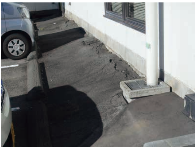
写真-5 抜け上がり現象
