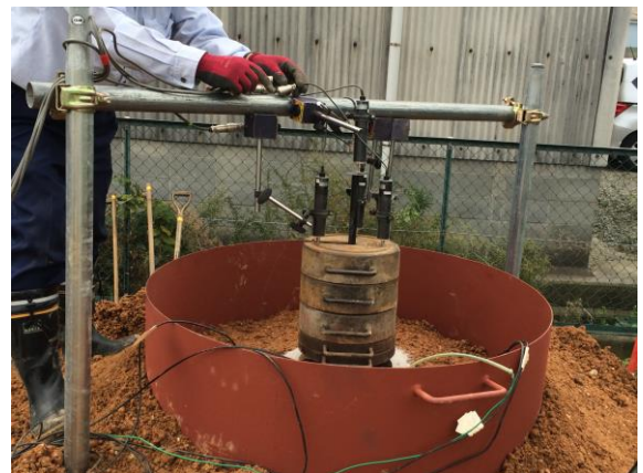
図-3.18 現場水浸試験の概況
