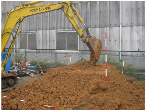
図-3.13 試験盛土造成の様子
