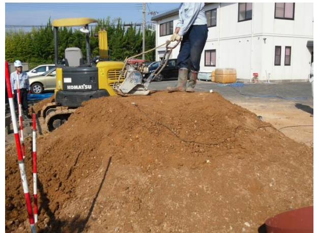
図-3.14 タンパーによる盛土の締め
