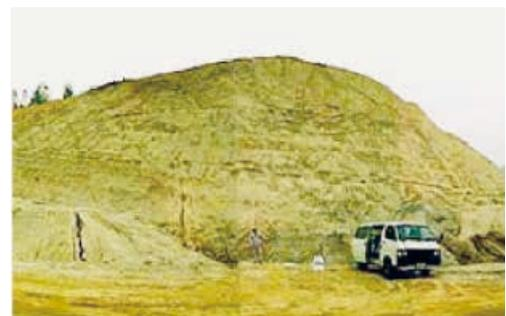
写真-2 深層風化状況の例 (20m以上)<sup>2)</sup>
