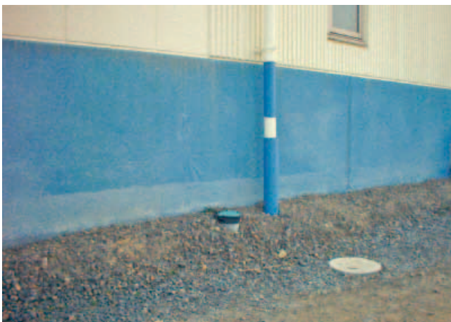
写真-4 配管のズレ
