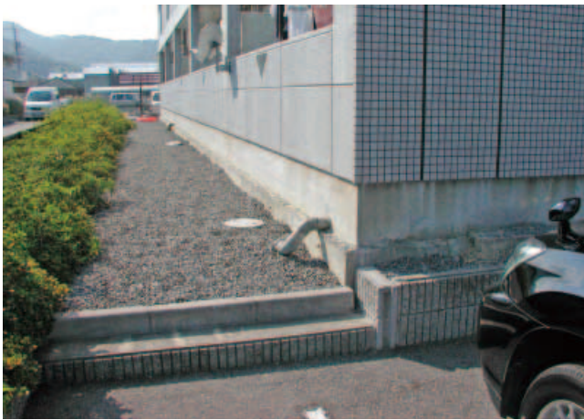
写真-3 露出した配管
