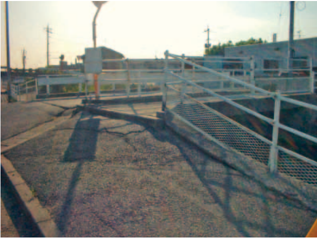
写真-1 接続部の段差
