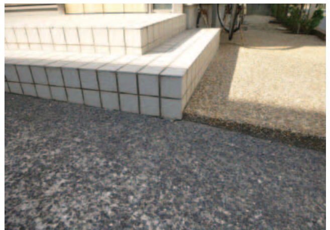
写真-6 問題のないアプローチ部
