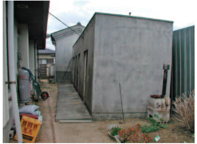
写真-2 傾いた倉庫
