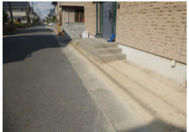
写真-5 抜け上がりしたアプローチ部
