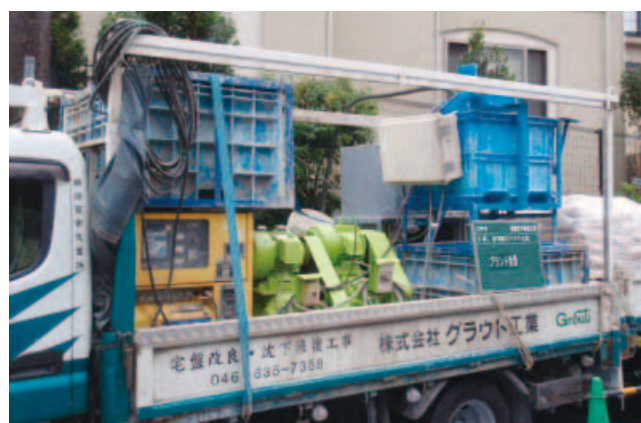
写真-2 車上プラント
