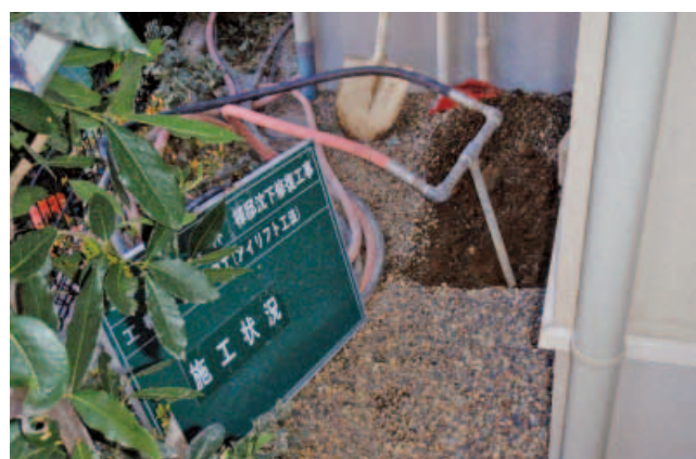
写真-4 施工状況（単管ロッド）
