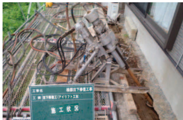
写真-3 施工状況（超小型ボーリングマシン）
