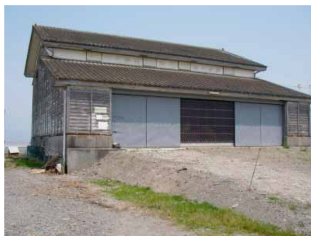
写真-2 抜け上がり現象に伴うスロープ作成状況（白石地区）
