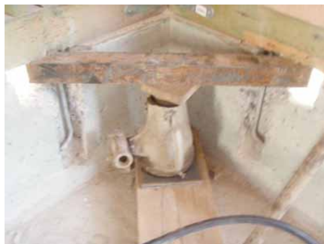
写真-2 架設鋼材の設置状況
