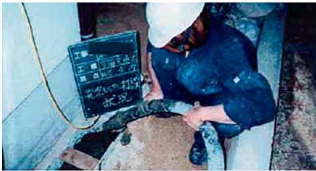
図-10 気泡モルタル打設状況
