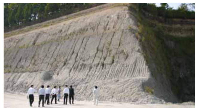
写真-1 垂直崖の侵食面を形成しているしらす地盤
