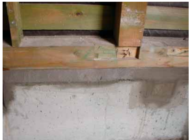
写真-5 モルタル充填状況
