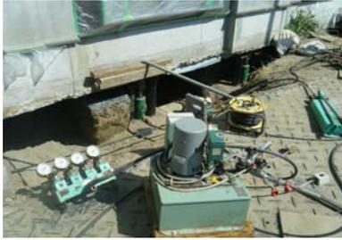
写真 3-2-4 沈下修復状況
