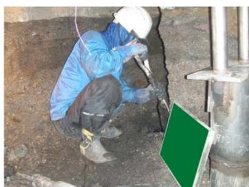
写真 3-1-1 基礎下部掘削
