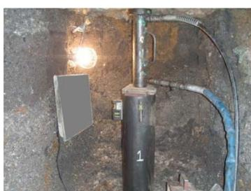
写真 3-1-2 鋼管圧入状況
