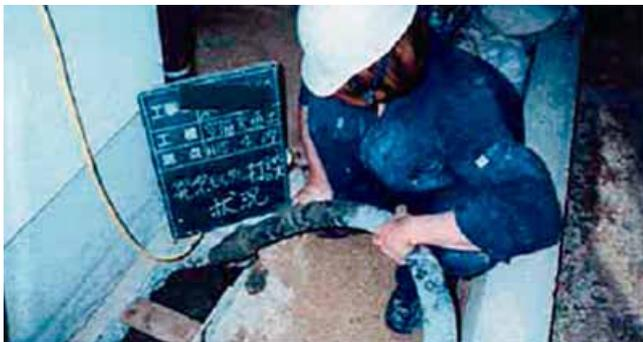
図-10 気泡モルタル打設状況
