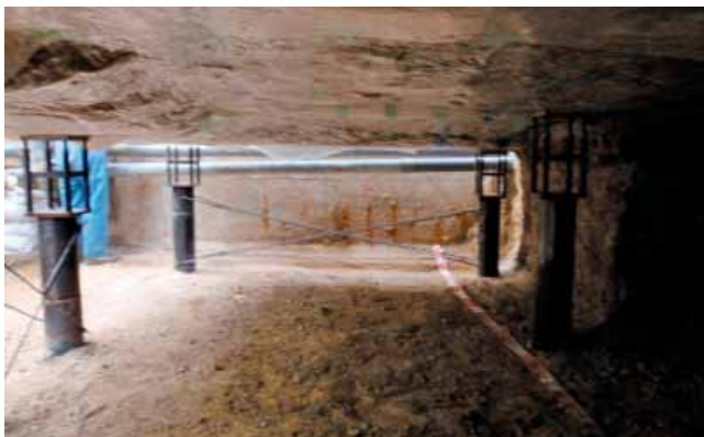
写真-3 変位抑止の補強
