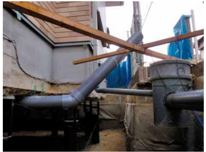
写真-6 埋戻し作業
