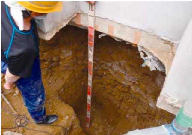
写真-2 掘削状況
