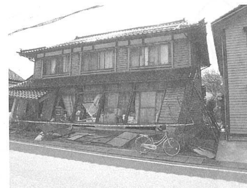
写真 1.1.1 日本の伝統的な家屋の地震被害 (2007年 能登半島にて)
