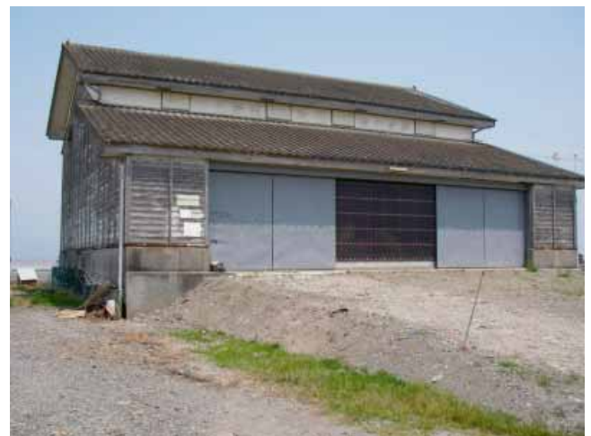
写真-2 抜け上がり現象に伴うスロープ作成状況（白石地区）
