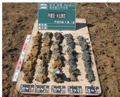
写. 土質確認状況
