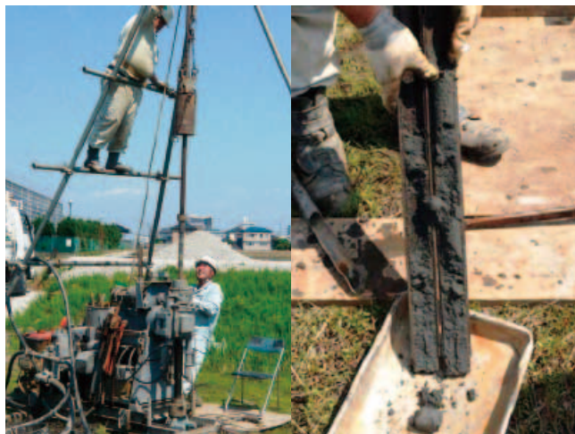
写真-6 SPT 試験状況
