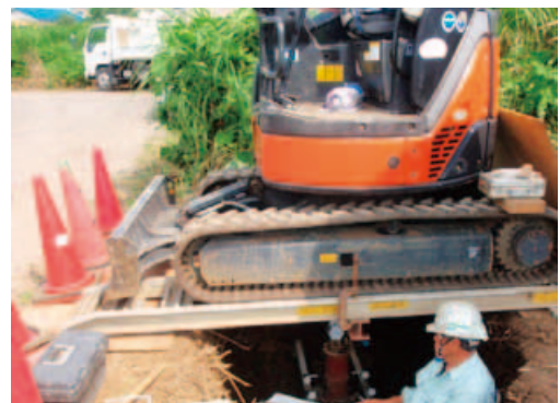
写真-4 平板载荷試験の試験状況
