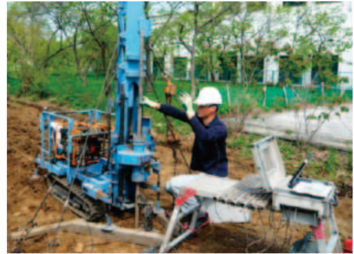
写真-2 電気式コーン貫入試験機
