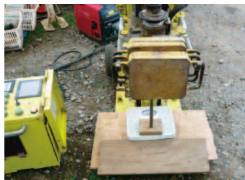
写真-11 ジョカルテⅢの荷重確認状況
