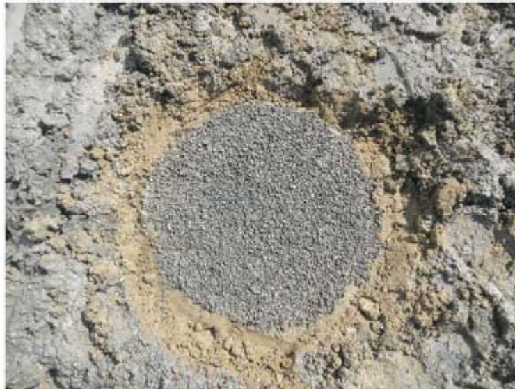
(写真-3) 単粒碎石による NUP グラベルドレーン杭
